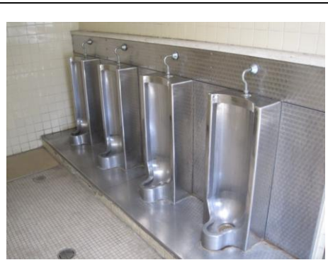
有明テニスの森のそばにあるステンレスの便器。サビや尿石の除去が大変だそうです。
