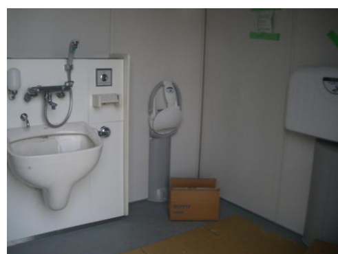
「KOOZA」では、トイレ専用のプレハブが設置され、オストメイト設備も設置された。
