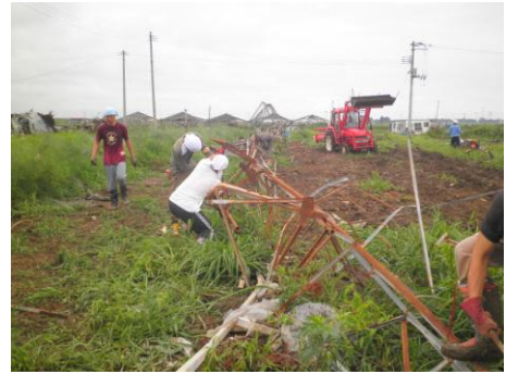
海水で錆びたビニールハウスを解体する
