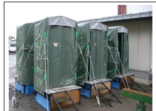
仙台市のテント式の組立トイレ。「段差もあるし風で揺れ、覗かれそうで怖い」と不評だった（写真提供：㈱総合サービス）
